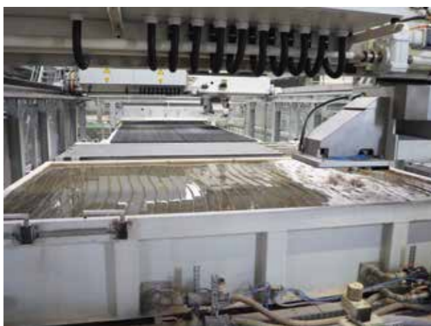
Jetstone-Bearbeitung bei Engineered Stone: Über die Zahnriemenbahn gelangen die Platten an die Doppelbrückensäge- und Wasserstrahlanlage, die auch Falzfräsungen und Bohrungen durchführt
